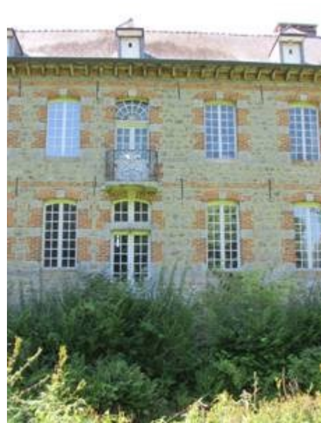
Emplacement de l'ancien pont-levis
