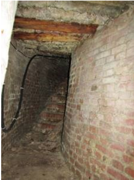
L'escalier de sortie, interdit au public. Une barrière en empêchait l'accès.
