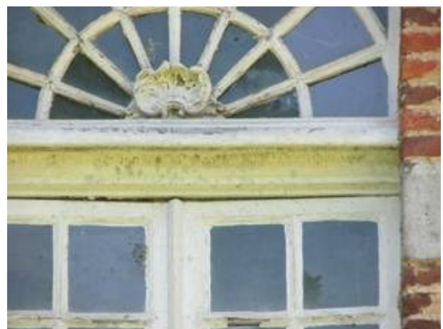
« Coquille » au dessus du balcon
