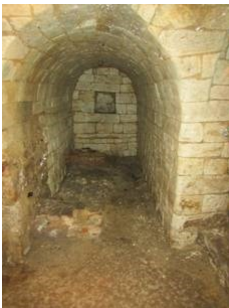
Plusieurs cellules ont une trappe sur le mur du fond.
