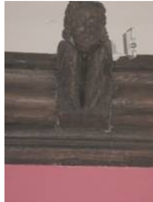
Tête de poutre intérieure
