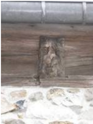
Tête de poutre extérieure
