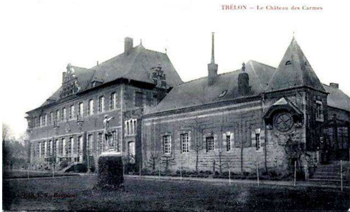
Façade avant du château.
