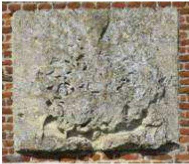
Une plaque martelée sur le mur des communs.
