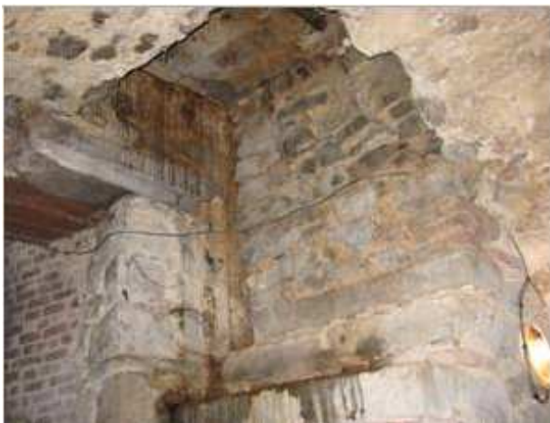
Le départ, muré, à Monceau
