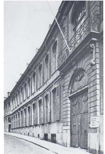
Mons, 18, rue d'Enghien, ancien hôtel du marquis de Gages
