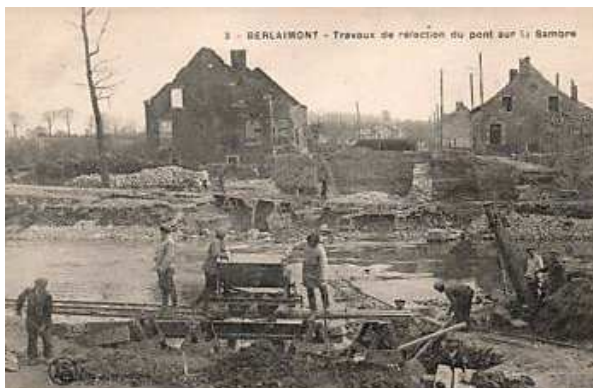
1919 - Travaux de réfection du pont.
